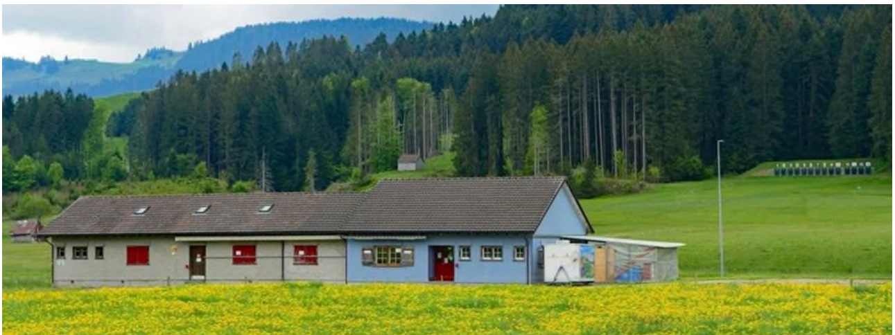
Schiessanlage «Sönderli Gonten»
