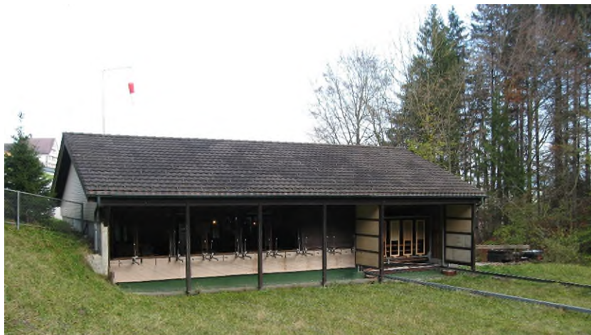
Schiessanlage «Geelhüsli Appenzell»
