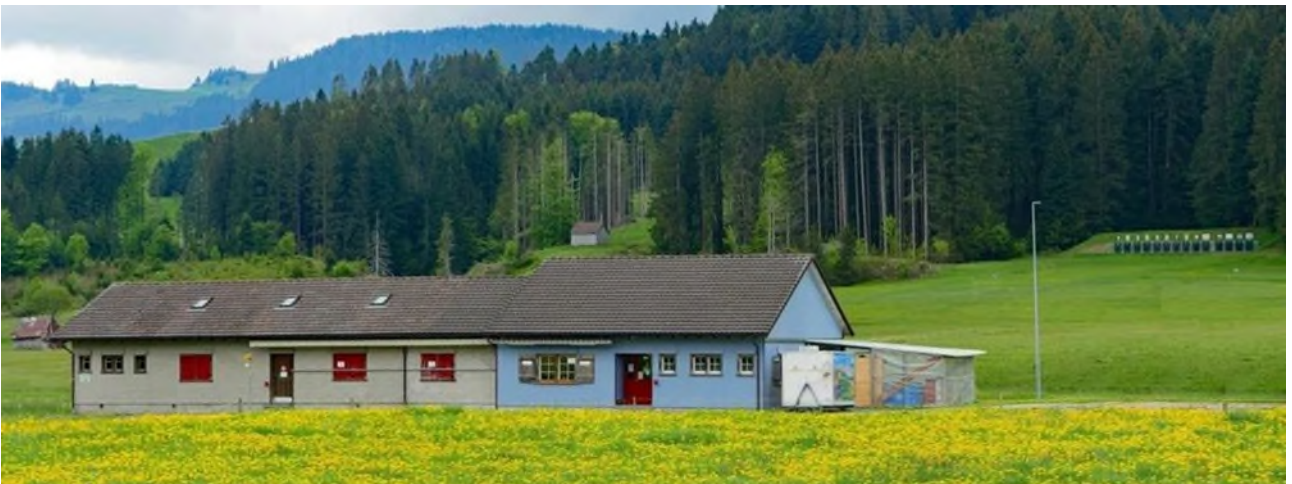
Schiessanlage «Sönderli Gonten»
